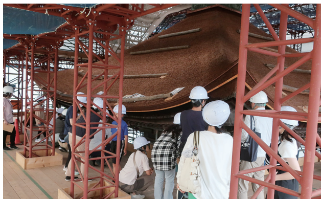
工事中の現場見学会
